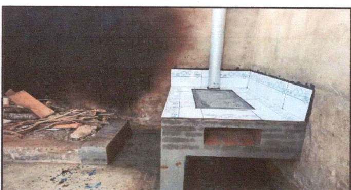
Foto 4: Remozamiento en el área de cocina con sustitución de estufa rural.
