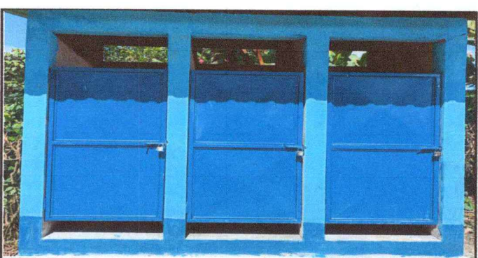
Foto 6: Sustitución de puertas de metal en servicios sanitarios.
