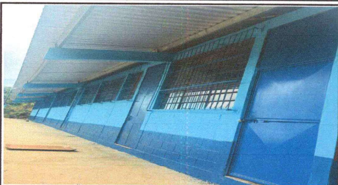
Foto 1: Trabajos en sustitución de puerta de metal en la Dirección, colocación de balcones y aplicación de pintura en paredes.
