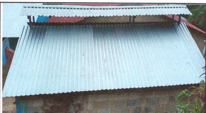
Foto 3: Ejecución del renglón cubierta de lámina en el área de cocina con la instalación de lámina troquelada calibre 26.
