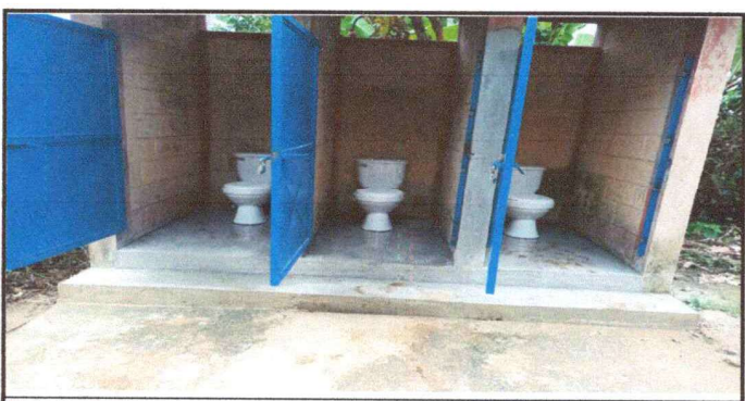
Foto 5: Remozamiento en los servicios sanitarios con instalación de inodoros.
